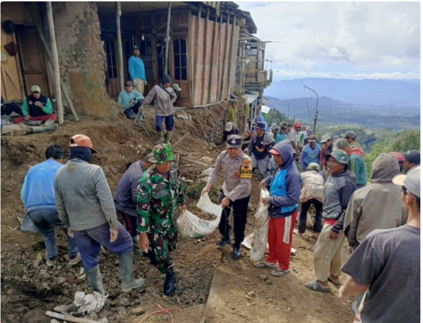
(Foto Dokumen) : Gotong royong pembersihan material longsor
